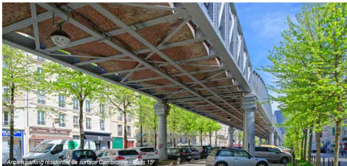
Ancien parking résidentiel de surface Cambronne - Paris 15 e
