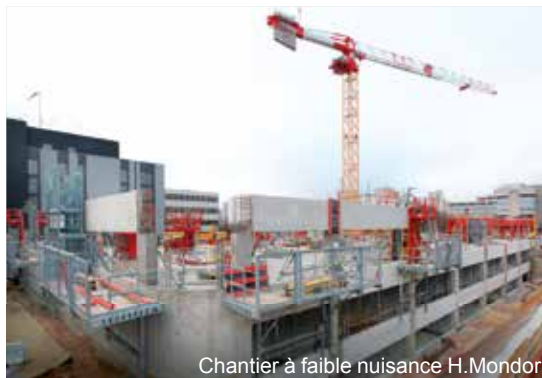
Chantier à faible nuisance H.Mondor
