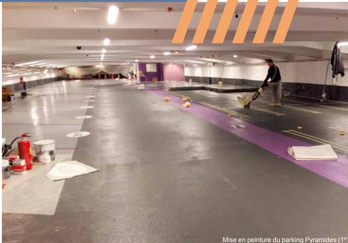
Mise en peinture du parking Pyramides (1 er )
