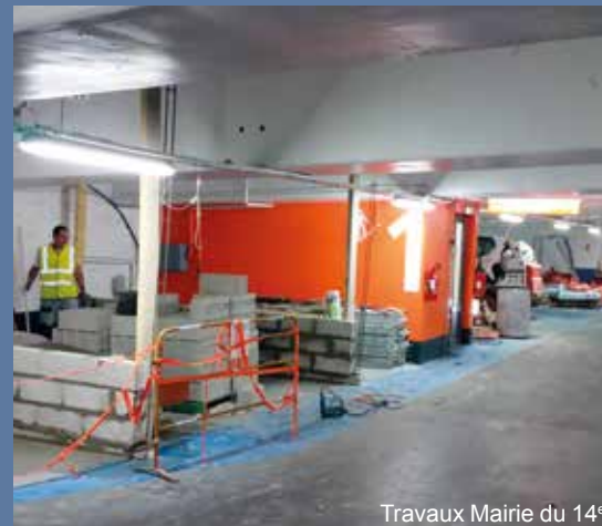
Travaux Mairie du 14 e
