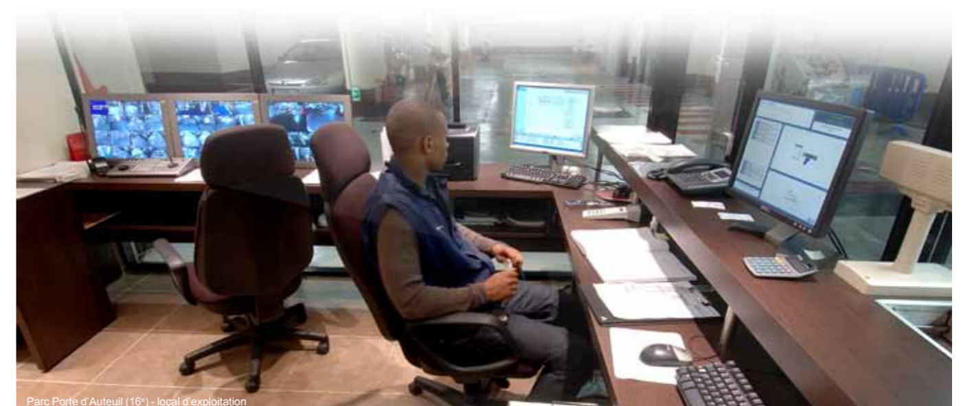
Parc Porte d'Auteuil (16 e ) - local d'exploitation
