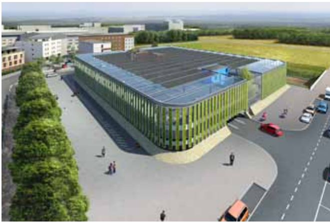
Vue architecte Parc Montévrain Val d'Europe
