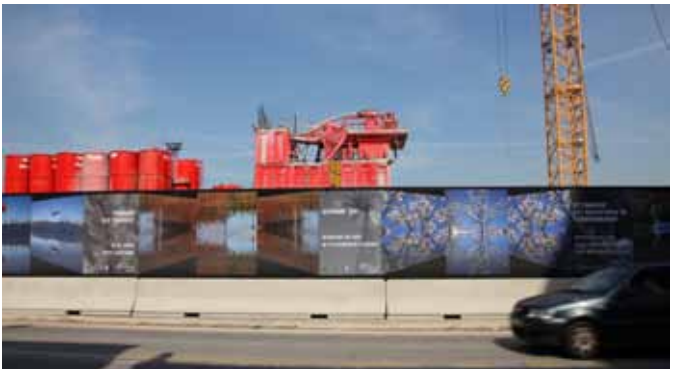
Chantier du parking Cardinet
