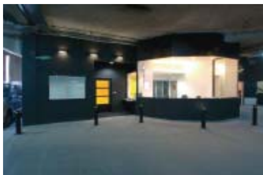
Saint Eloi Paris 12 ème (rénovation en cours de finition été 2009)
